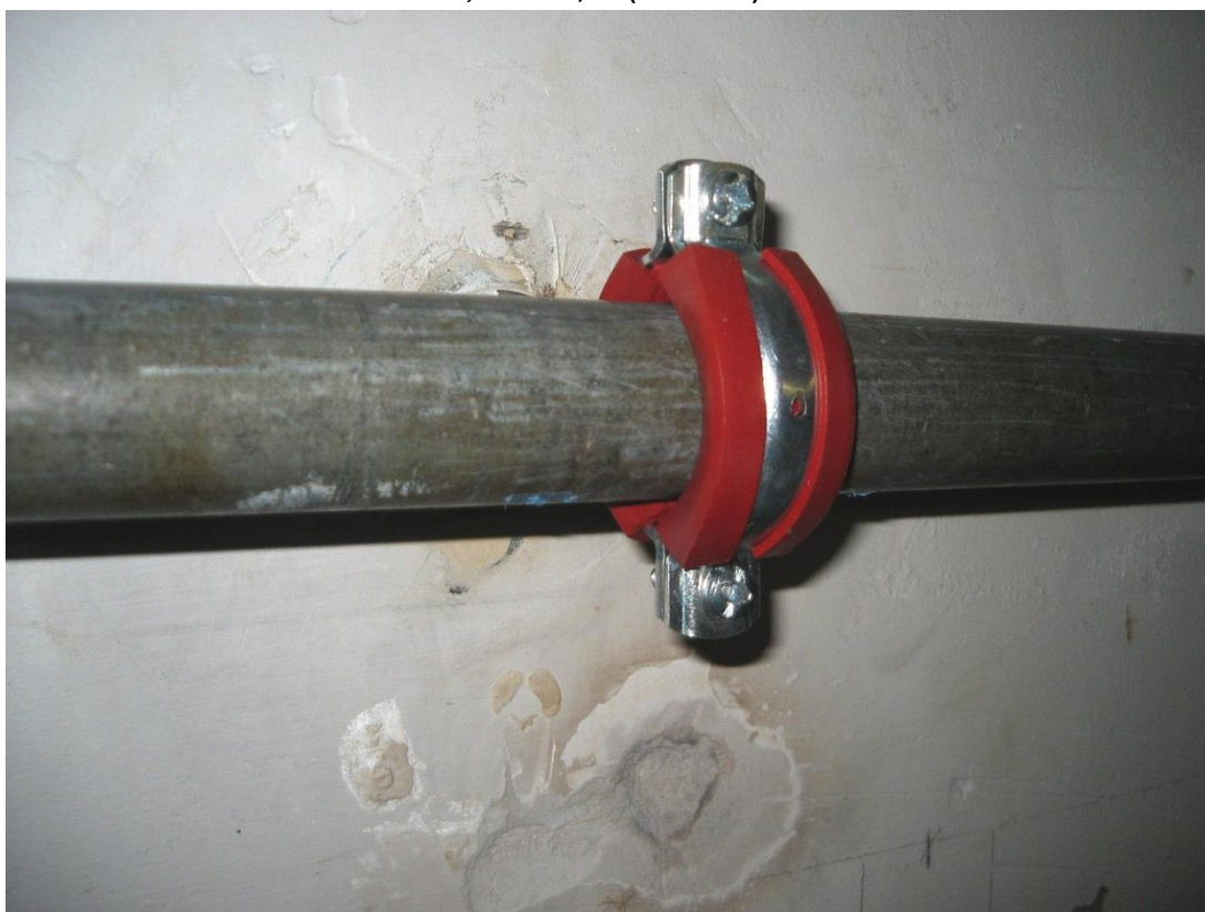
Bild 2: Schraubroherschelle DÄMMGULAST® rot, M8/M10, 1" (32-38mm)
