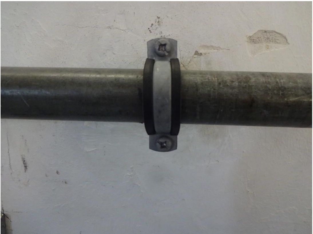
Bild 4: Schraubroherschelle mit DÄMMGULAST® schwarz, 1" (32 - 37 mm), M10, feuerverzinkt mit Schalldämmeinlage
