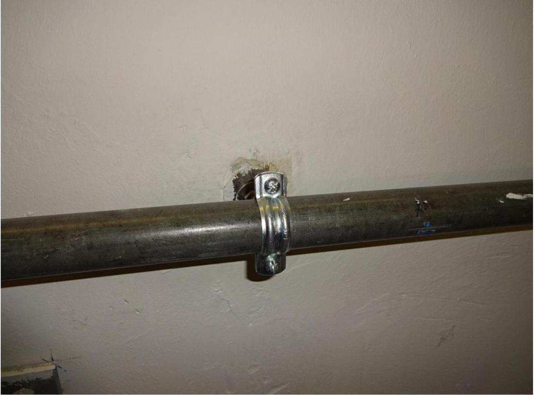
**Bild 2: Schraubrohrschele Euro Quick, Typ Exp, M8, 1" (33-37 mm), verzinkt**
